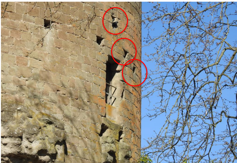
Figure 1 : Emplacement des cavités de la tour d'Hermance visitées le 10.4.2022, vue depuis le portail du parc
