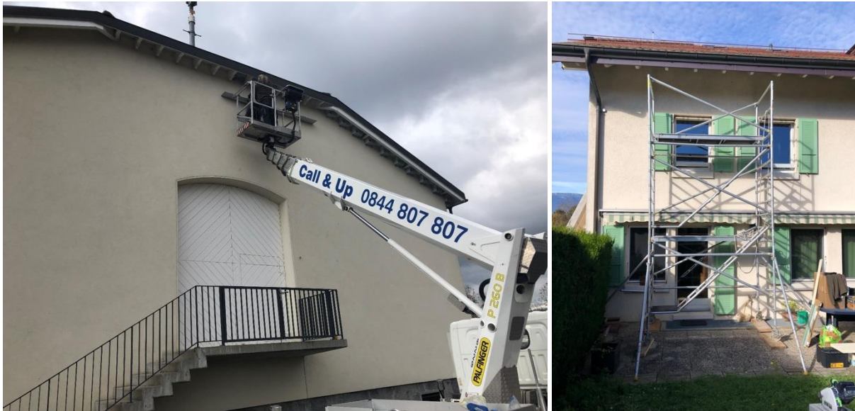
Photos 1 et 2 (Plan-les-Ouates et Bernex) : À gauche, installation de 10 nids et de 2 planchettes anti-salissures sur l'École primaire, à l'aide d'une nacelle. À droite, lorsque la hauteur d'intervention dépasse 3 m, un échafaudage ou une nacelle sont obligatoires.
