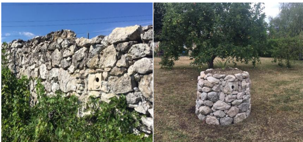
Figures 2 et 3 : Exemples des deux types de cavités installées : à gauche, un nichoir est intégré dans un mur du vignoble ; à droite, un édifice en forme de puits a été construit en intégrant un nichoir - Photos : Christine Jaggy-Duplessis
