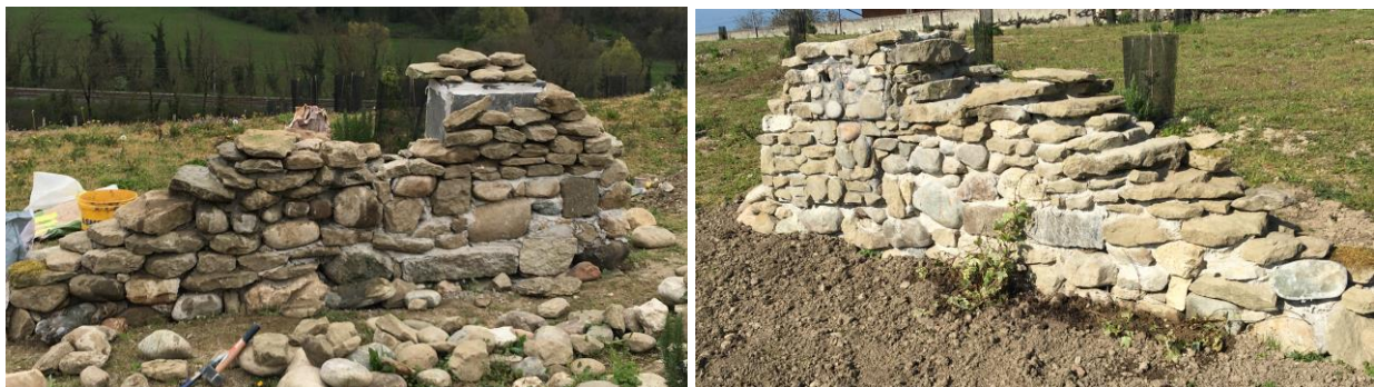
Figures 3 et 4 : Premier chantier dans la région du Mandement. À gauche, la construction du mur et à droite, le mur terminé avec la cavité artificielle.
