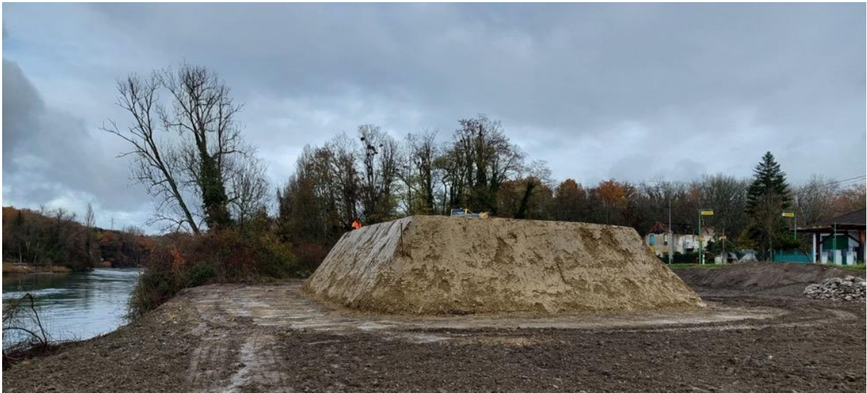
Photo 1 (29.11.2022) : La butte de Chancy dans son gabarit quasiment définitif (il manque la couverture, ~40 cm). Les deux faces visibles seront encore taillées en mars 2023 pour les rendre plus verticales et faire apparaître le sable favorable aux hirondelles (ici masqué par le coffrage). Photo : C. Pochelon
