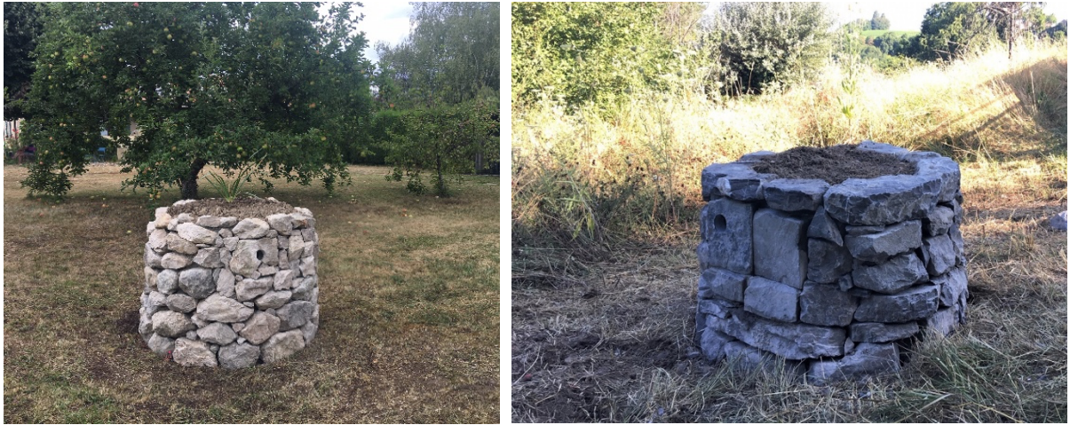
Figure 6 et 7 : Deux édifices en formes de puits ont été construits en intégrant des nichoirs à Huppe fasciée. Photos : Christine Jaggy-Duplessis
