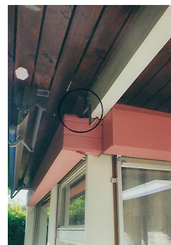
4. coffrage de store
